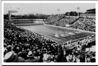
▲夜間照明もある大プール
