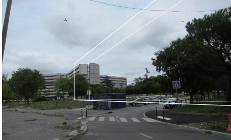
図 16 レイスラー地区の住棟撤去後の状況 2
