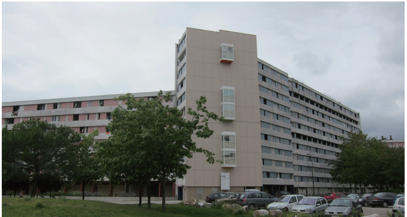
図1 ル=ミライユ団地の切断された住棟（写真中央の出窓がある壁から手前に住棟が伸びていた）
