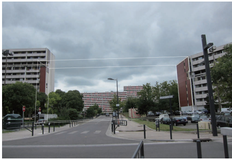
図 15 レイスラー地区の住棟撤去後の状況 1
