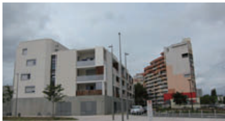
図 17 レイスラー地区の新築棟 (左) と改修棟
