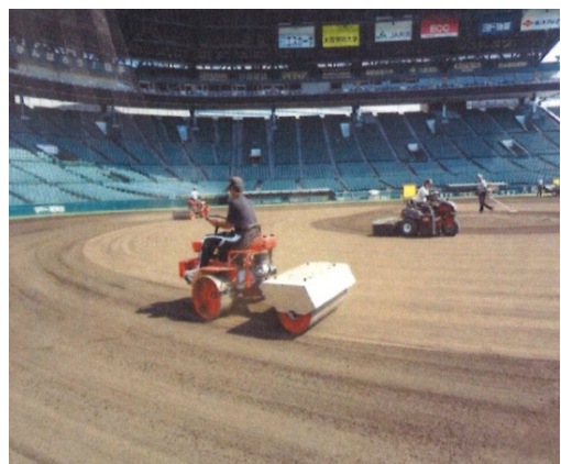
図 31. 整地・締固め
