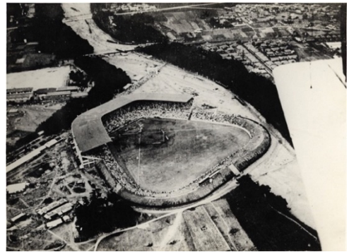
図6. 竣工当時の全景（大正13年（1924））
