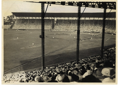
図9. アルプス屋根の完成時 昭和6年(1931)
