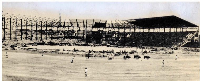
図 4. 工事中的様子（大正 13 年（1924））
