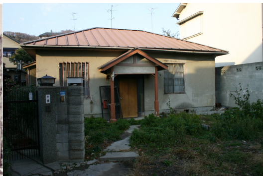
図5 平成18年解体前のナオミの家
