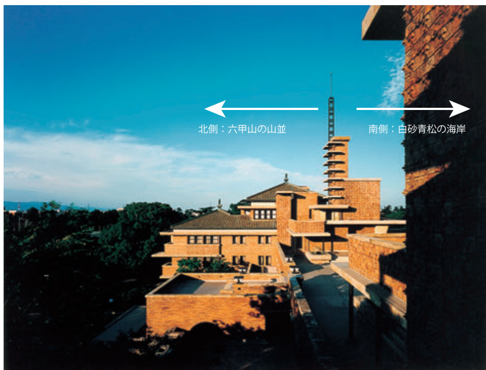
図 4-1 甲子園ホテル3階の屋上テラスとそこから南北に得られる眺望
