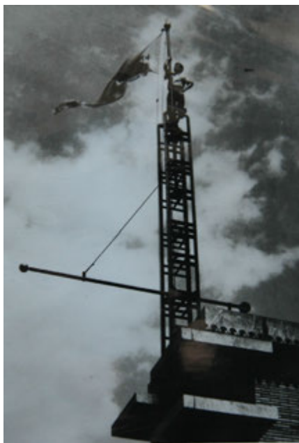
A: 竣工時の状態（水平金属棒が存在）
