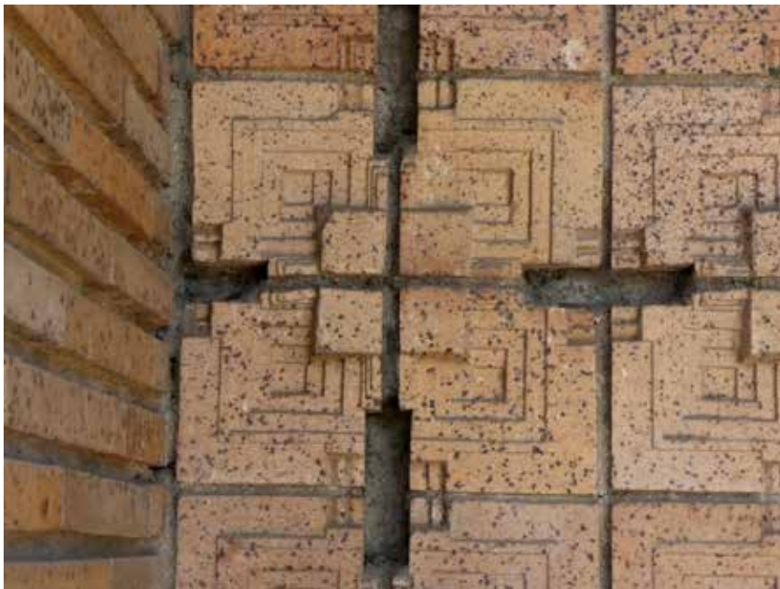
図 8 甲子園会館 屋上壁面タイル(詳細) 著者撮影 2017
