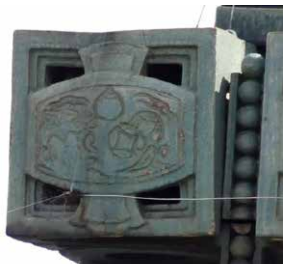
図7 甲子園会館 屋根 相輪露盤（部分）著者撮影 2017
