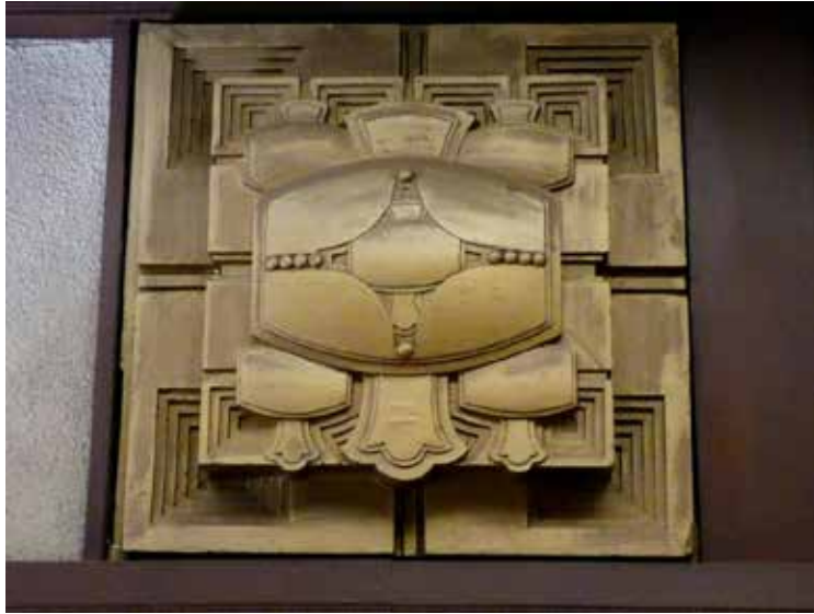
図9 甲子園会館西ホール入口 装飾(打出の小槌) 著者撮影 2017
