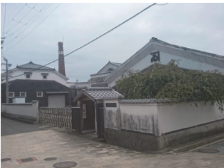
写真3 醤油蔵ゾーン
